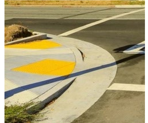
ADA Curb Ramps
