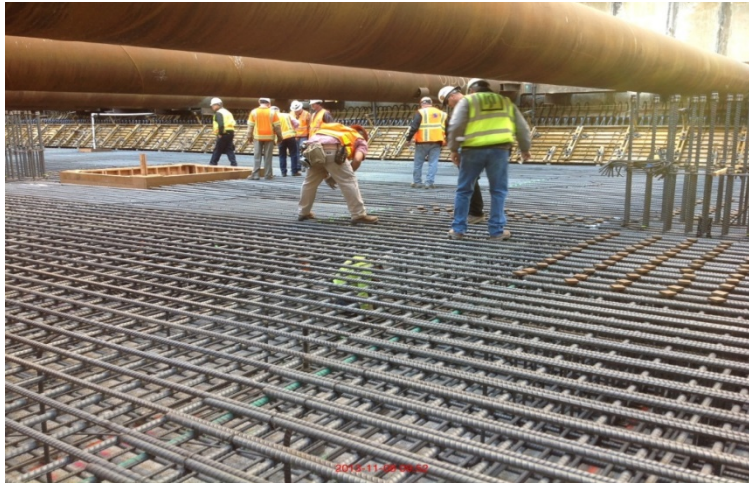
Rebar inspection prior to concrete pour
